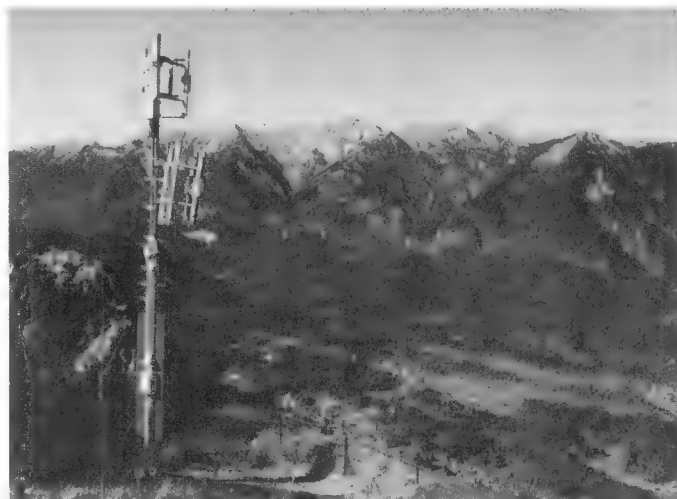
Bild 2. Doppel-Abstrahlantenne auf dem Kreuzeck mit vertikaler Polarisation
