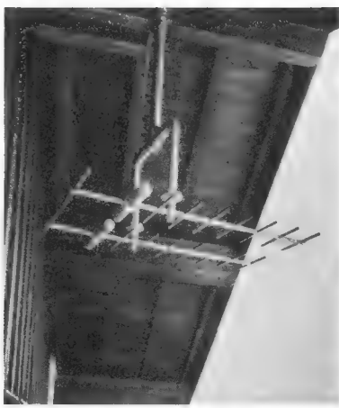
Bild 4. Doppel-Yagi-Antenne mit je neun Elementen als Empfangsantenne des Umsetzers unter dem östlichen Vordach der Bergstation
